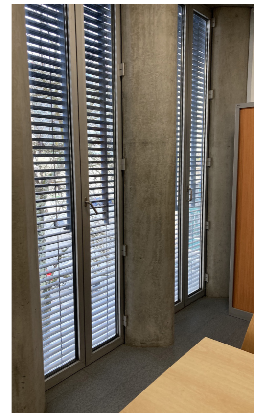
Vue intérieure des fenêtres de la tour «Rogers»
