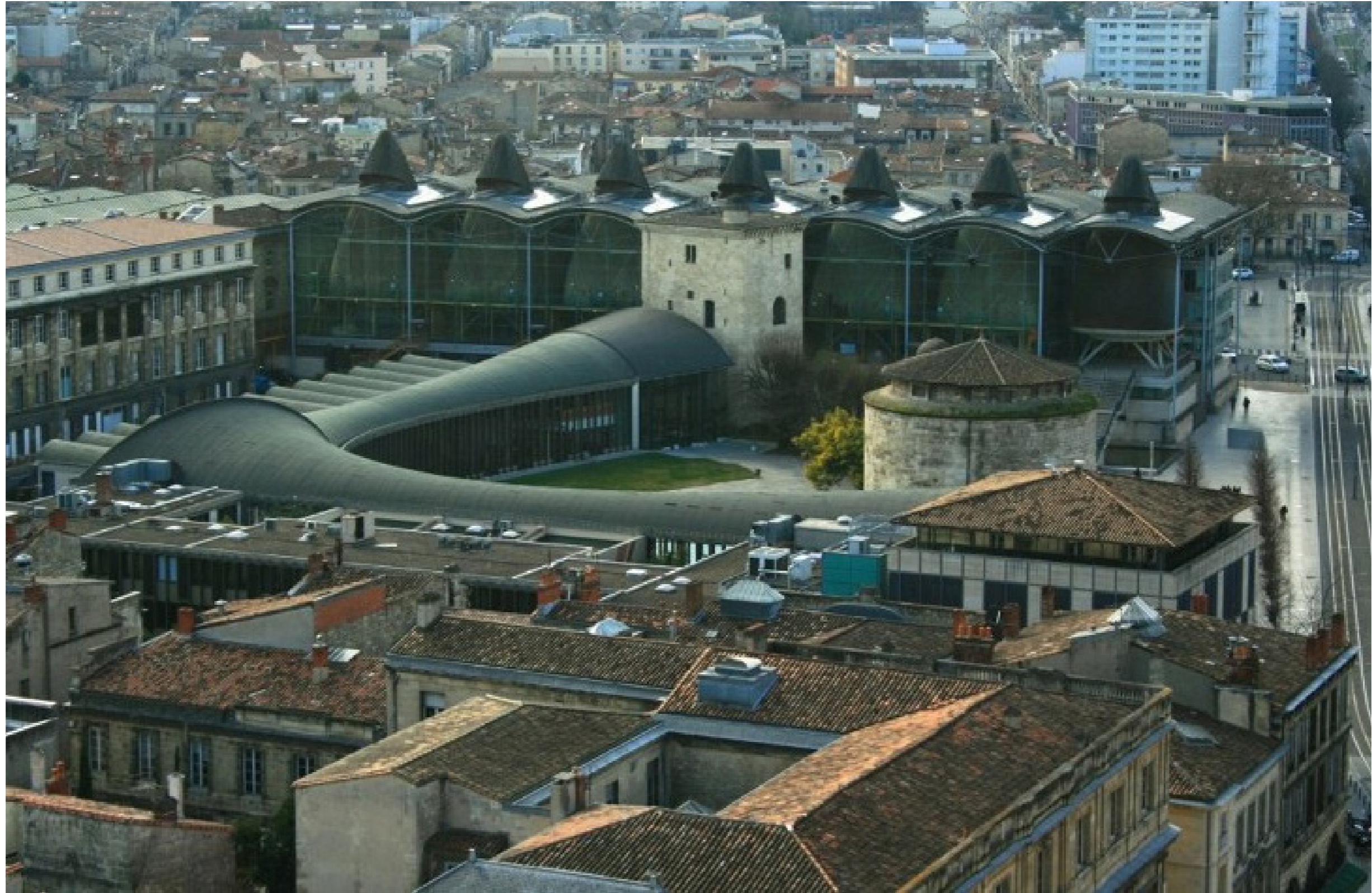
Vue de la tour «Rogers» depuis la Tour Pey-Perland
