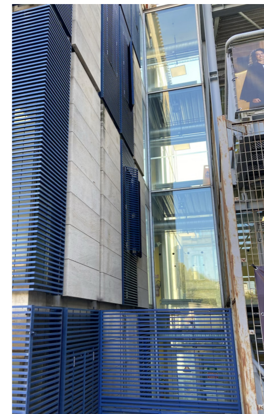
vue du mur rideau de la tour de service
