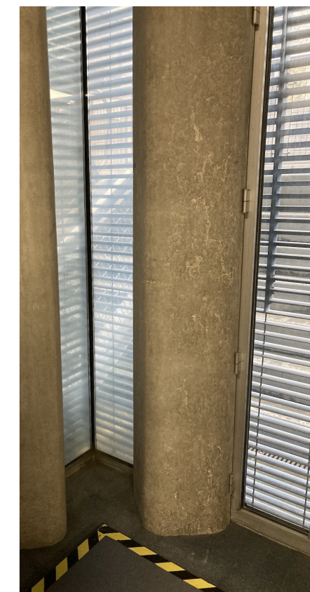
Vue intérieur d'un châssis d'angle
