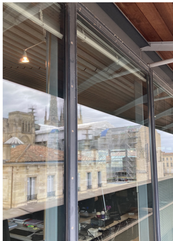
Vue du mur rideau du 4ème étage
